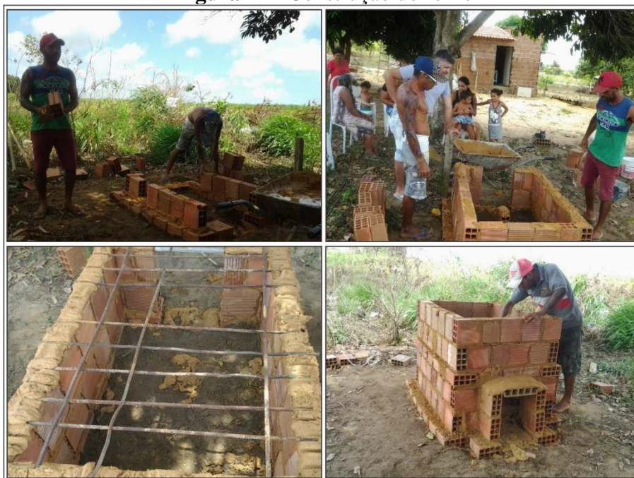
Figura 42 - Construção do forno
